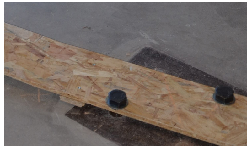
Ancrage de la rive en OSB au sol
