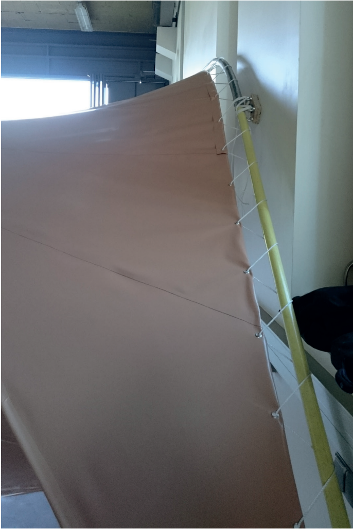
Toile principale attachée par des oeilletons et de la drice à une arche fixée au mur
