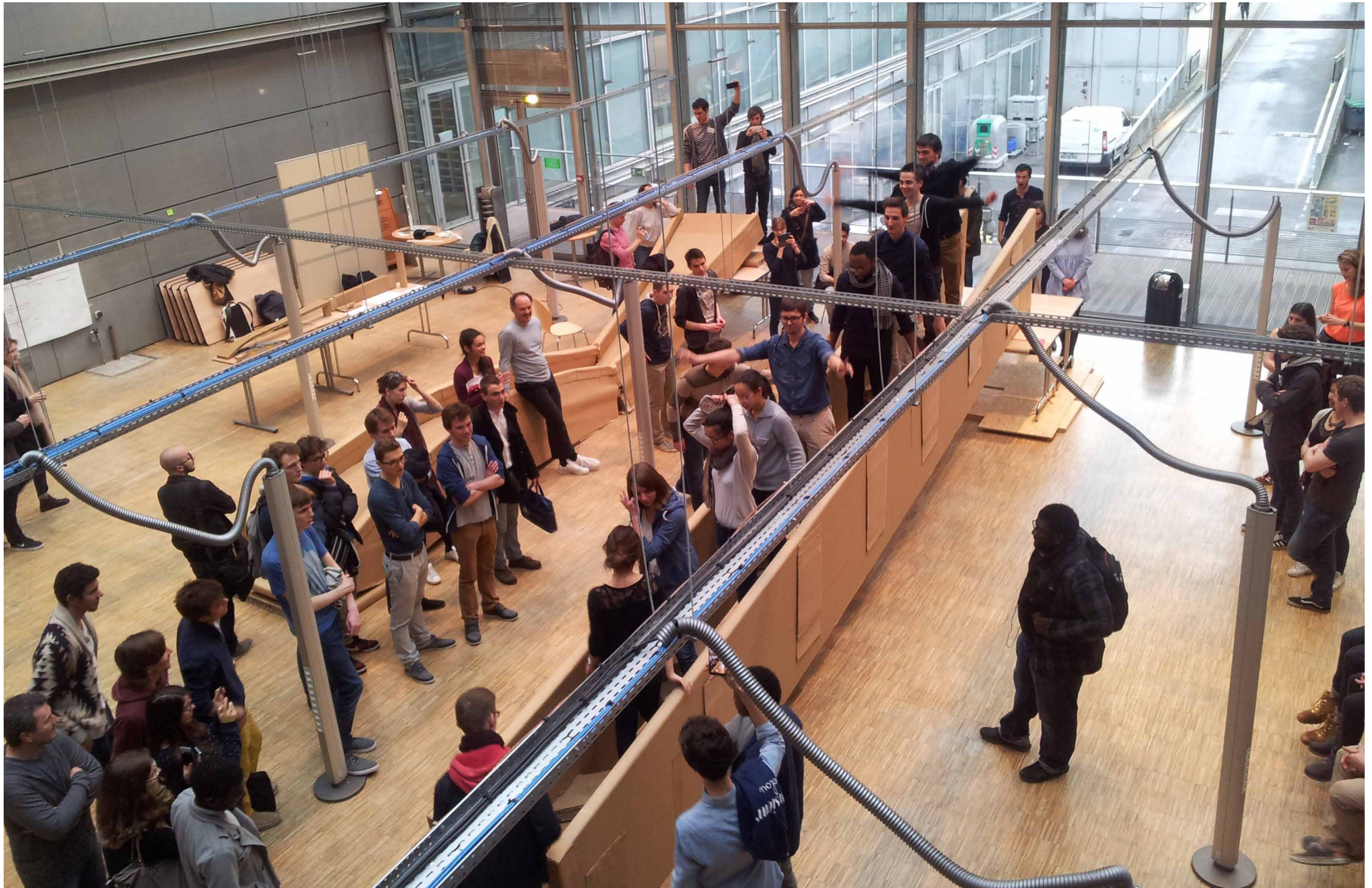
Toute l'équipe au grand complet (environ 620 Kg) tient sur la passerelle qui remplit tous les critères énoncés dans l'exercice!
