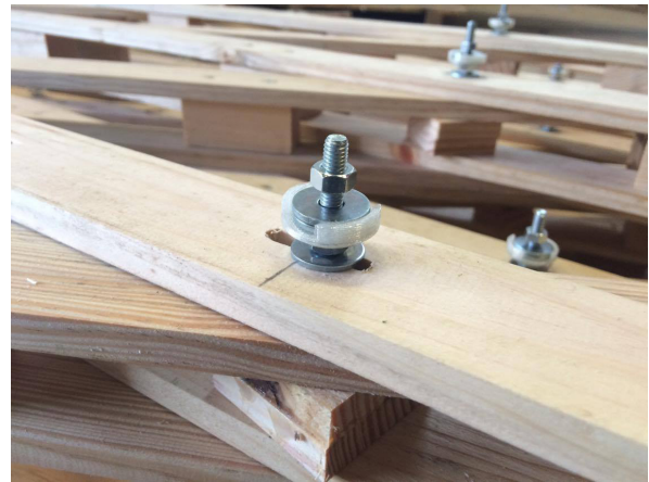
Montage des nœuds sur les modules du Gridshell en atelier
