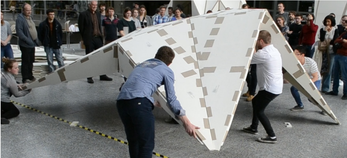
Etape 3 La structure étant symétrique, le pli s'opère sur une des parties pendant que l'autre coté se rapproche et se pli sans forcer.
