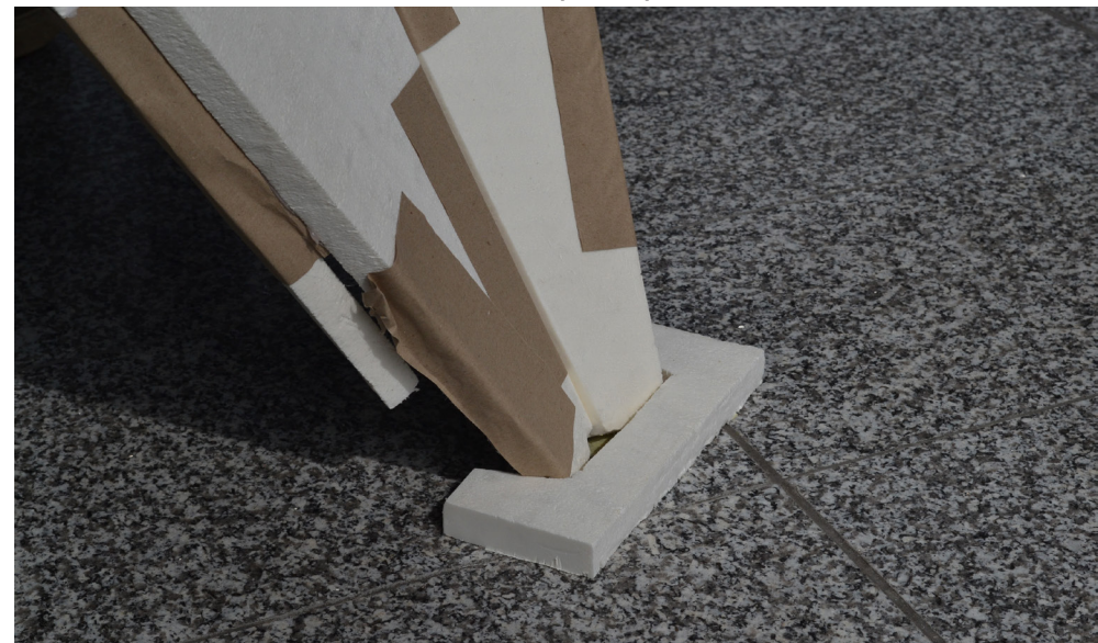
Zoom sur l'encastrement en pied qui sécurise la structure
