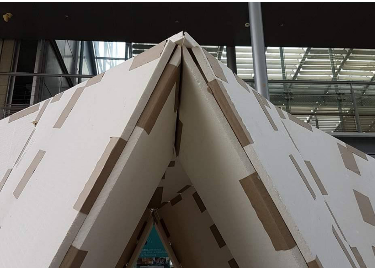
Assemblage au toit avec 6 plaques biseautées
