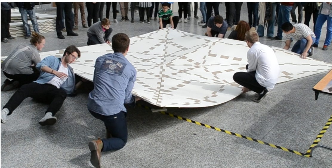
Etape 1 Deux étudiants mettent en tension les 4 plis montagnes se situant sur le toit.
