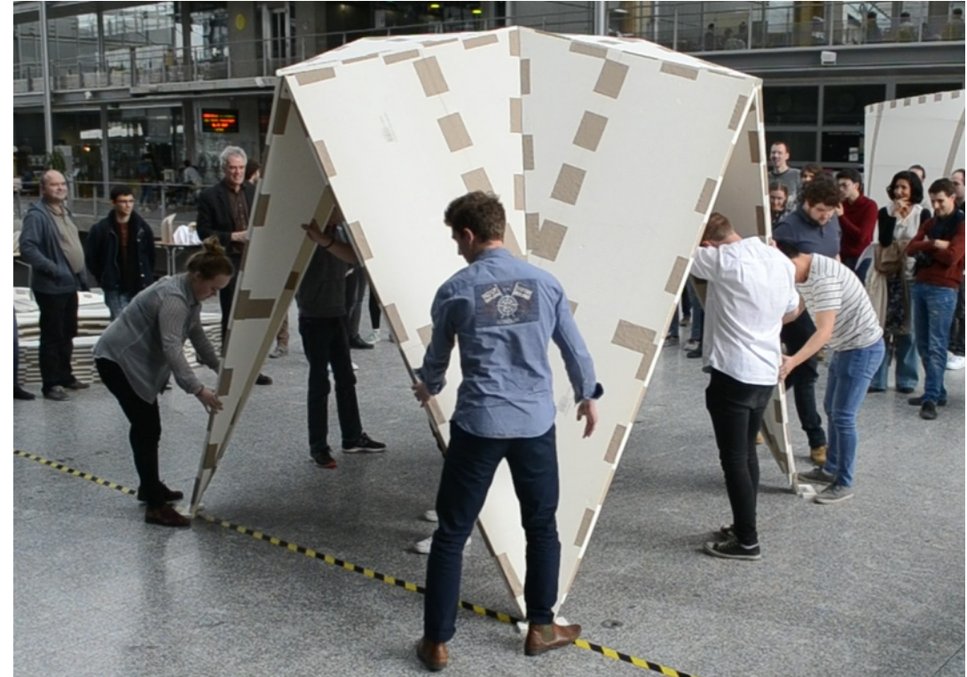
Etape 4 Le calage des pieds encastrés permet de sécuriser la structure. Le montage est ainsi terminé.
