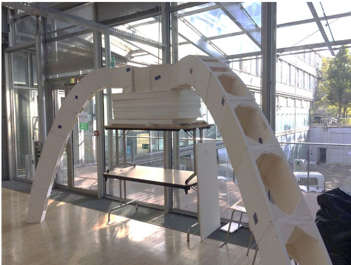
Processus de montage de la structure (appui provisoire du demi-tore)
